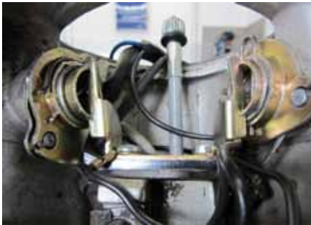
5. Gas- und Schaltrohre mit Innenrohren komplett montiert.
